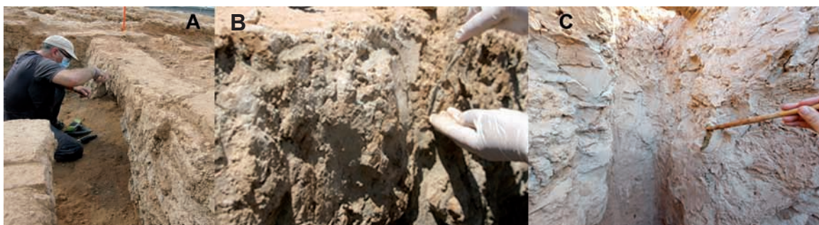
Figura 3. A, Proceso de limpieza. B, Aplicación de mortero. C, Consolidación por impregnación.
